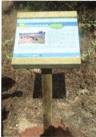
La instalación se resuelve con una zapata de 300 x 300 mm y una profundidad de 300 mm realizada con hormigón HA-25 colocándose en el interior la parte inferior de la baliza de madera, al cual se le incorpora un elemento conectivo metálico (clavos, tornillos) o se realiza una hendidura para su sujeción. La parte superior de la zapata quedará cubierta con materiales del entorno.
