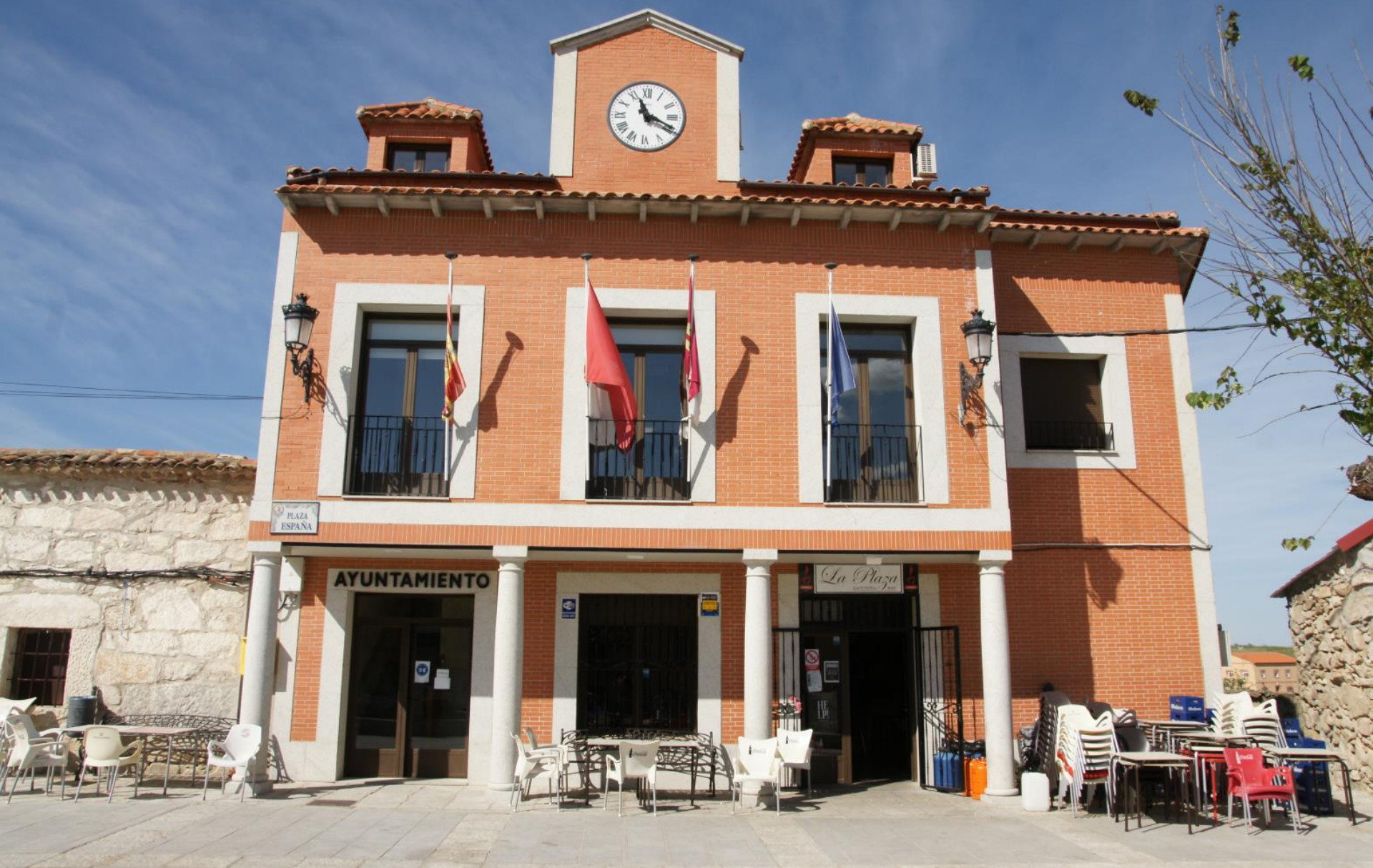
AYUNTAMIENTO SITO EN PLAZA ESPAÑA, PLAZA PRINCIPAL DEL MUNICIPIO
