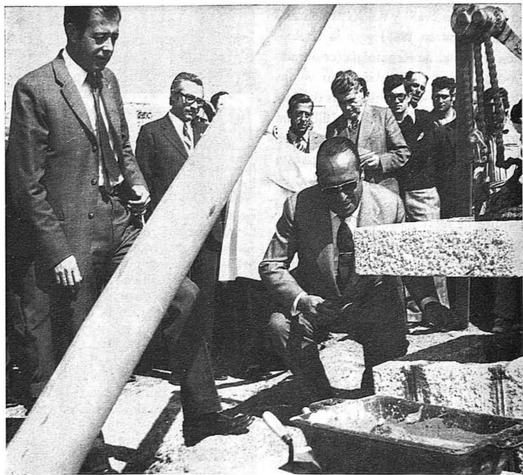
El Gobernador Civil de Toledo coloca la primera piedra de las nuevas edificaciones
