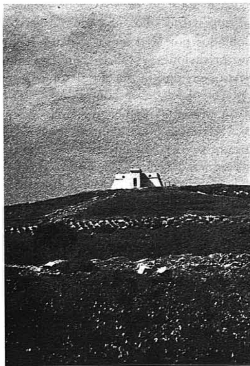
El depósito de agua que abastece a los habitantes de la villa.
