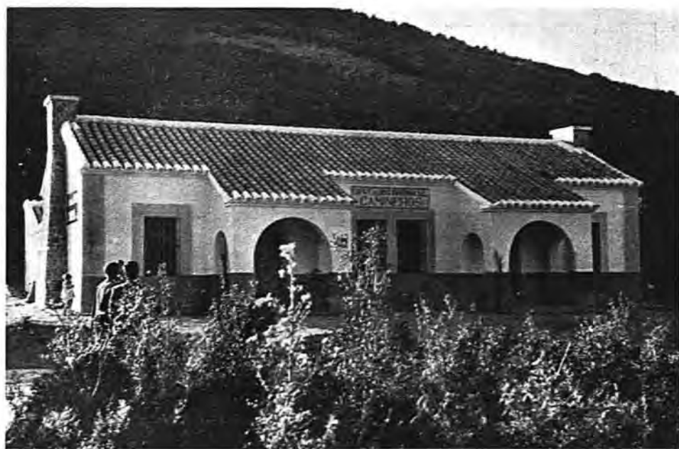
Casilla para dos peones camineros construída en el camino vecinal de Navamorcuende a Real de San Vicente
