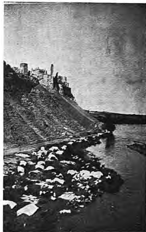
Lado oriental del castillo, bañado por el río Alberche
