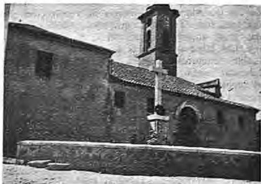
Fachada norte de la iglesia parroquial de Belvis, antes de su restauración. En primer término, la Cruz de los Caídos; al fondo, la torre, de esbelta figura
