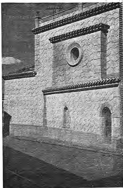
Fachada occidental de la iglesia de Belvis, después de su restauración
