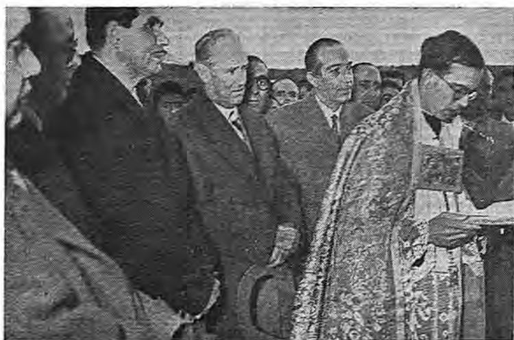
Un momento de la bendición del transformador
